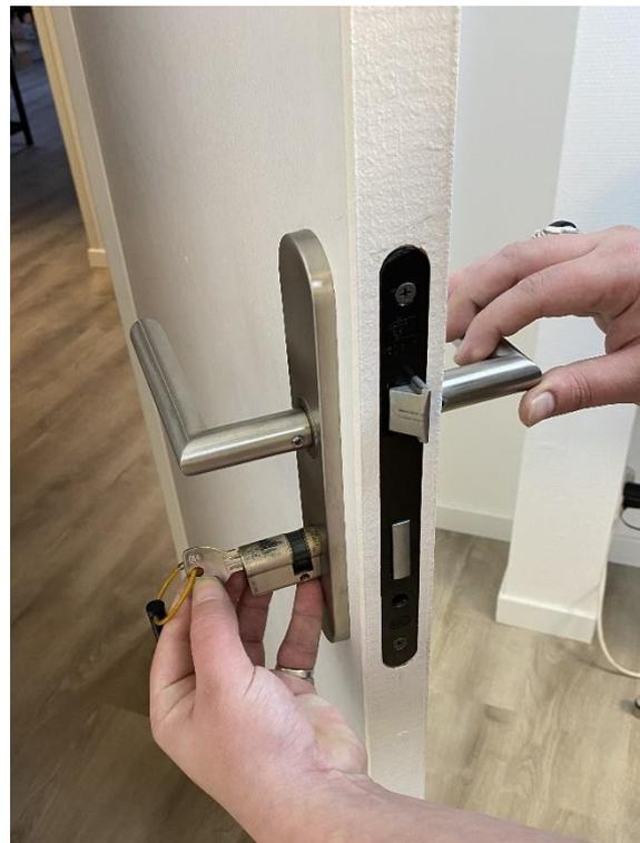
A l'aide de la clé du cylindre retirer le cylindre
